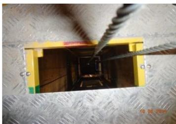
工作平台地台中間設有開孔可供導向吊船的鋼纜通過，同時可供導向吊船運行作無棚安裝
