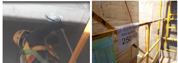
由合資格人士檢驗及簽發表格五，工作人員可在合規格的工作平台上設置救生繩及進行吊線測量工序。
