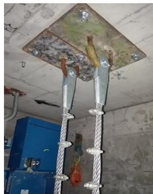
於上雙層工作平台可輕鬆地在井道頂架設導向吊船的懸吊點及設置懸吊系統
