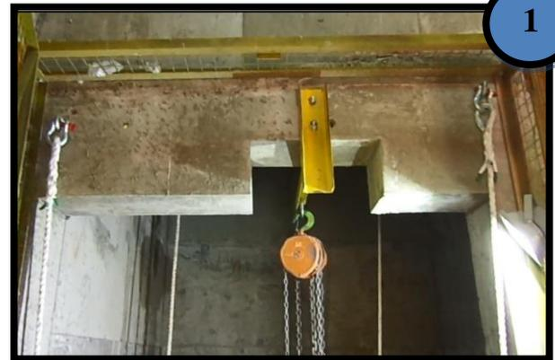
在頂層門外安裝兩個牢固點供工作人員使用及設置吊重設備，並經由註冊專業工程師檢驗。
