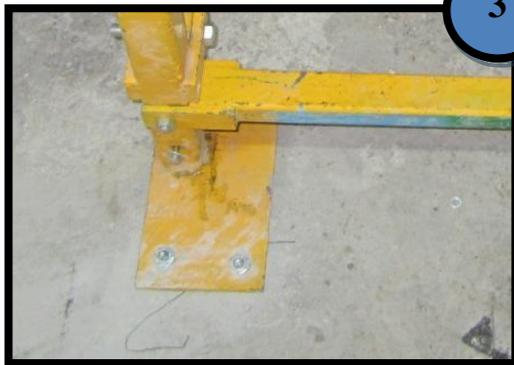
在井道外以拉爆鑼絲固定整固工作平台
