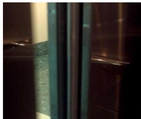
其實電梯門邊的重開裝置，只爲了在緊急情況下備用而安裝的設備。因此不要濫用重開裝置設備，阻礙電梯門關閉。而正確令電梯門重開的方法是使用機身內的開門按鈕，使機身門重開。
