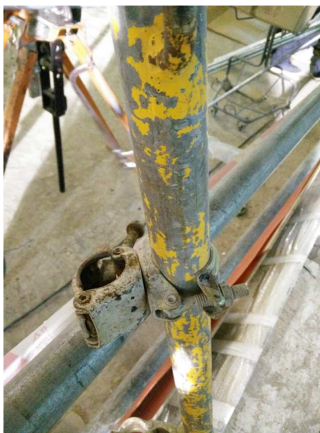
圖六及圖七：組合方法二（欄杆企柱配以金屬通）
