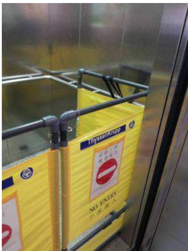
強化後的臨時圍欄能豎直及緊貼機箱門口。
