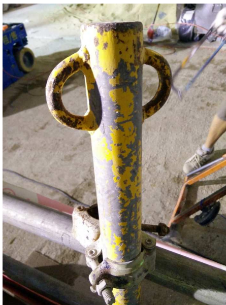
圖四及圖五：組合方法一（欄杆企柱配以鋼纜）
