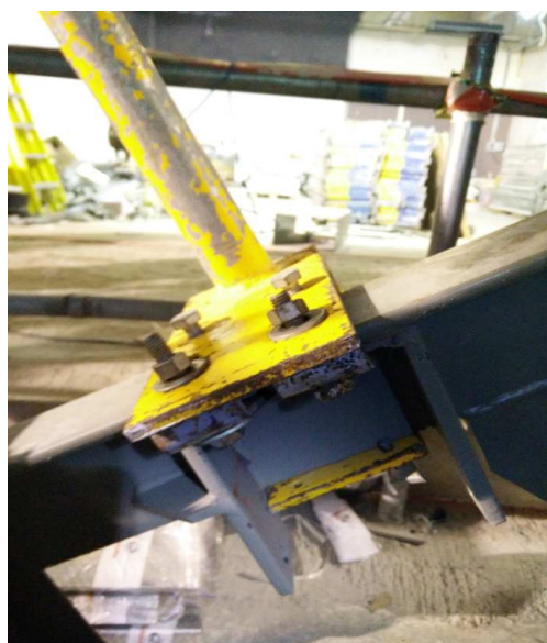
圖二：欄杆企柱正面
